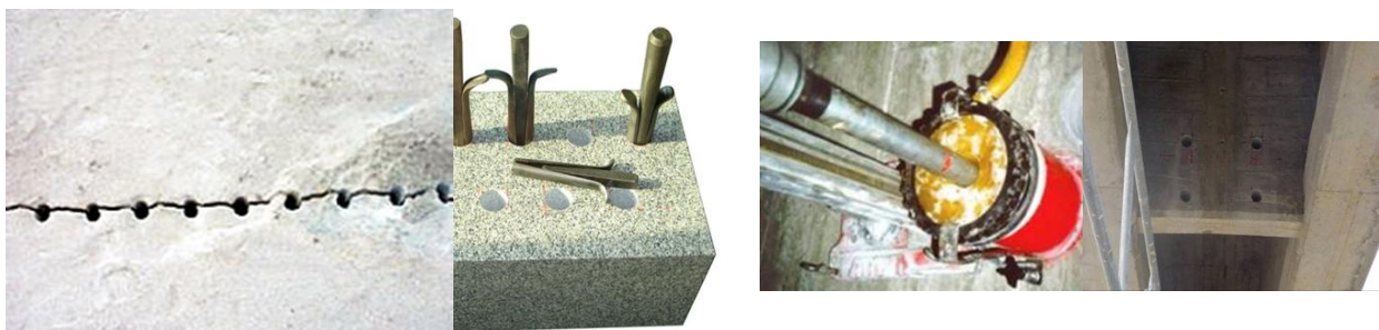
Figura 13: Remoção do betão por pre-splitting
