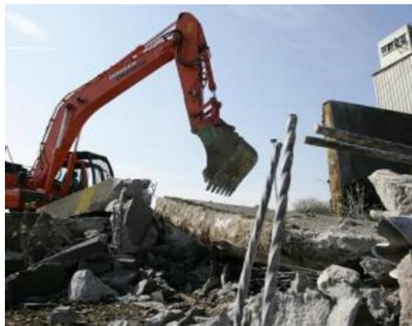
Figura 9: Remoção do betão por esmagamento
