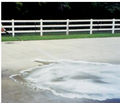
Figura 2: Limpeza química da superfície do betão
