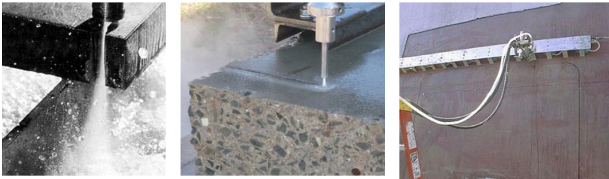
Figura 10: Remoção do betão por corte
