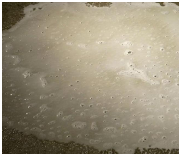
Figura 6: Limpeza por ataque químico da superfície do betão
