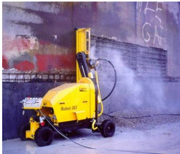
Figura 12: Remoção do betão por abrasão
