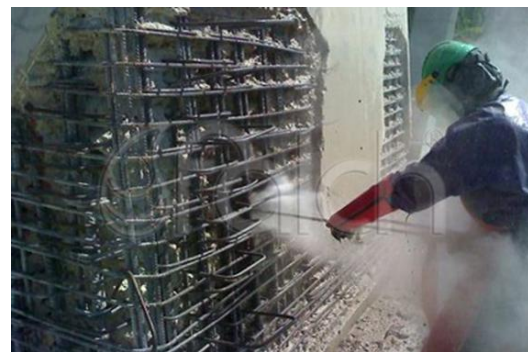
Figura 7: Limpeza das armaduras por escovagem e por jato de água
