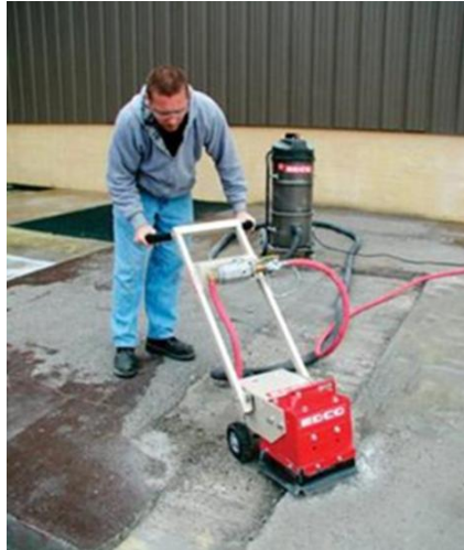
Figura 3: Limpeza mecânica da superfície do betão
