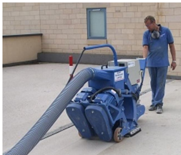
Figura 4: Limpeza shot blasting da superfície do betão
